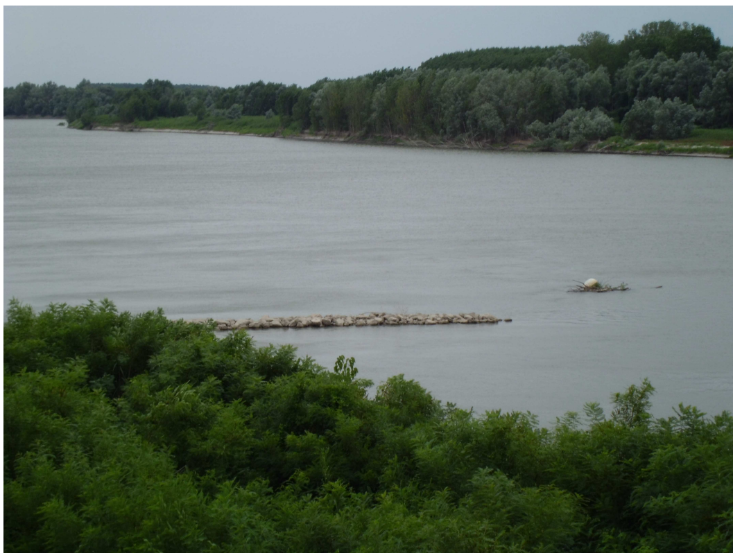
Figura 9. Castelmassa, pennelli esistenti in sinistra idraulica oggetto di completamento.
